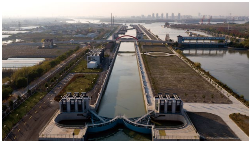
大芦线西枢纽新建二线新船闸
