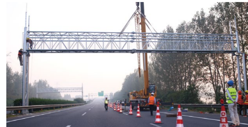
上海城投公路完成取消高速公路省界收费站应急工程 ETC 门架吊装任务
