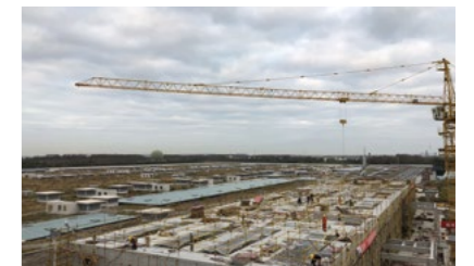
白龙港污水处理厂提标改造工程除磷池主体结构砼浇筑
