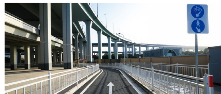
崧泽大道跨线桥人非设施工程
