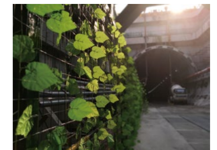
周家嘴路隧道建设中垂直绿化施工围挡，构筑绿色生态工地
