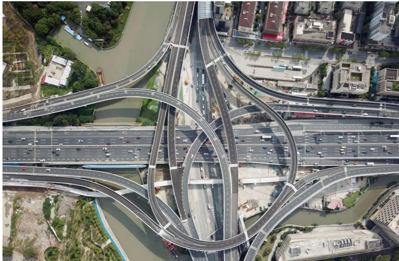
北横通道北虹立交安全互通工程通车
