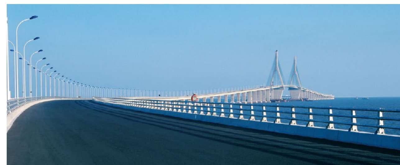
上海城投公路顺利完成洋山港智能集卡示范运营项目涉及东海大桥监控设施整治工程，为进博会期间洋山港智能集卡自动驾驶演示提供了良好的道路运行环境
