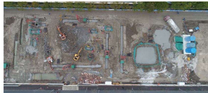
长桥水厂深度处理工程开工
