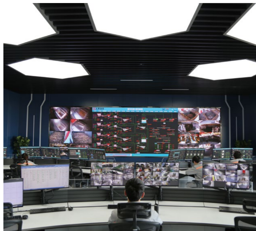
老港生物能源再利用中心是上海市规模最大的湿垃圾资源化处理设施
