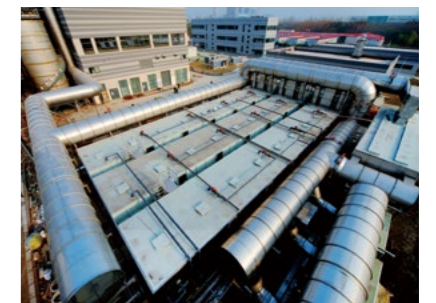
石洞口污泥设备安装就位
