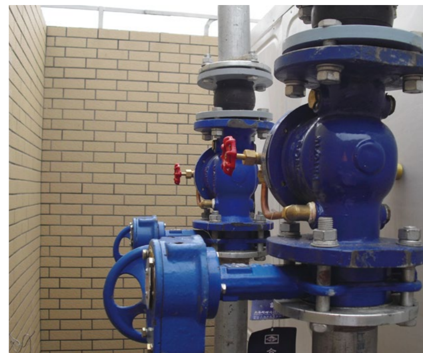
二次供水设施改造
