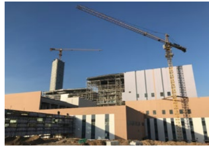
太原焚烧项目
