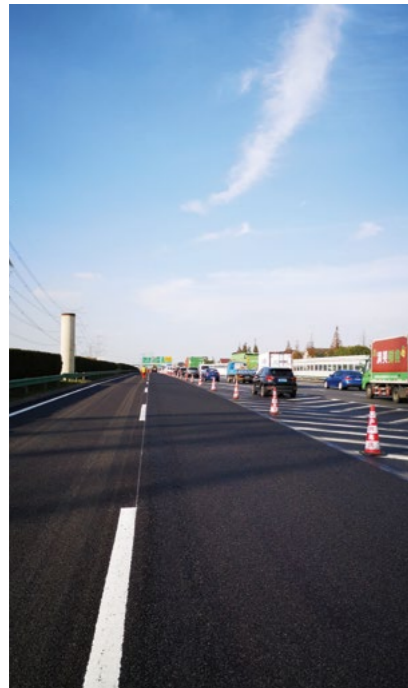
S2 沪芦高速公路开展专项整治，为进博会期间交通安全畅通提供保障
