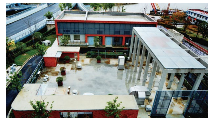
丹东排水系统工程
