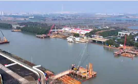
方厅水院施工实景图
