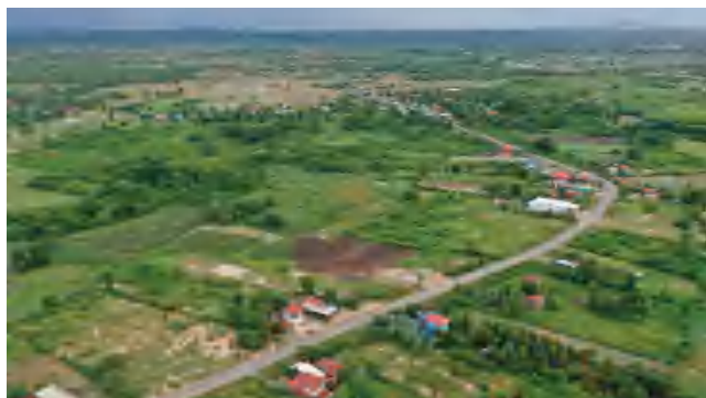
柬埔寨国家六号公路工程
