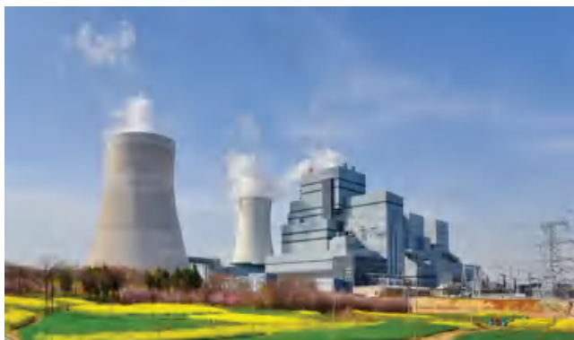
申能安徽平山电厂二期工程
