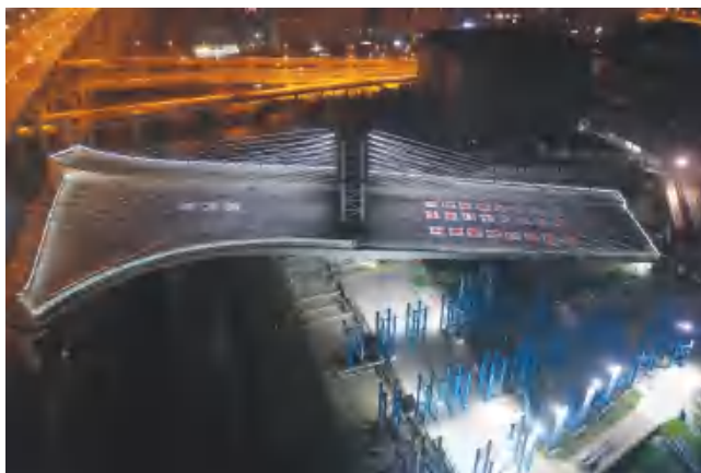
漕宝路快速路新建工程实现国内首座超宽三维不对称转体桥成功转体
