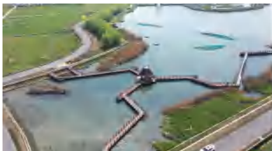
水乡客厅蓝环青浦先导段提前竣工
