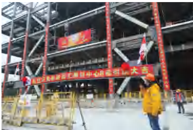
2022年12月30日，虹桥品汇B栋顺利封顶
