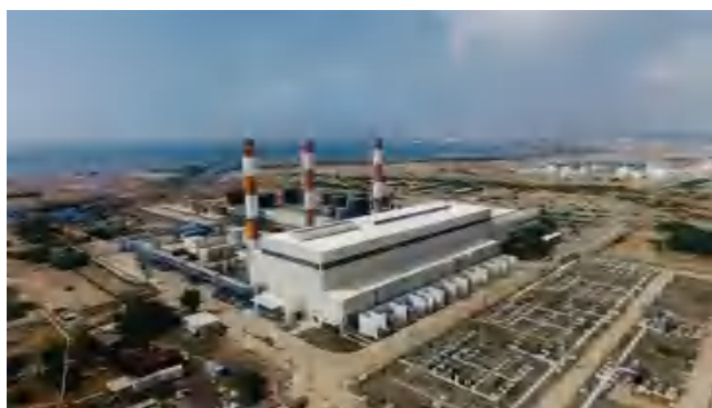
厄立特里亚 HIRGIGO 电站扩建工程
