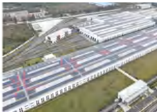
封浜车辆基地分布式光伏航拍图
