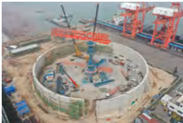
广西华谊氯碱项目建设中
