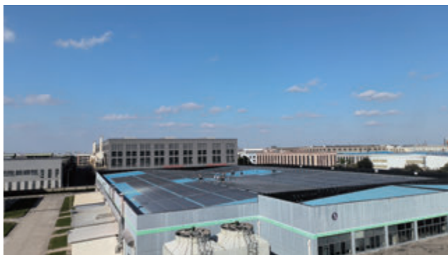
屋顶光伏电站
