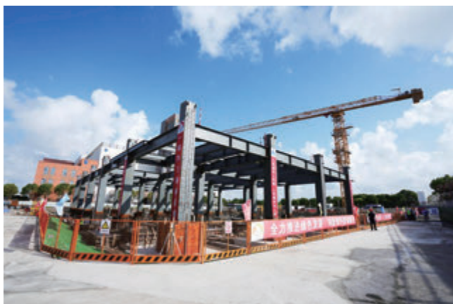
钢结构吊装现场图
