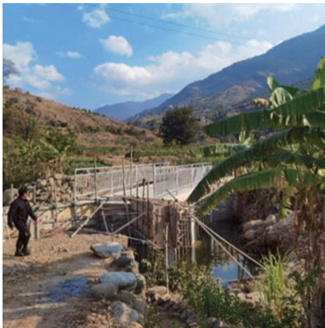
灰坝村造桥修路现场
