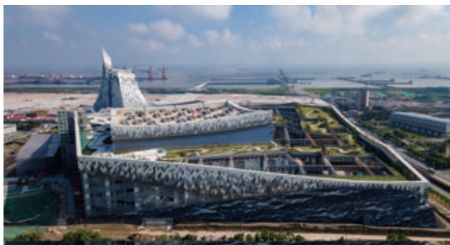
宝山再生能源利用中心项目实景图
