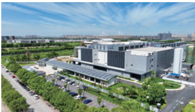
支持万国数据绿色节能示范工程
