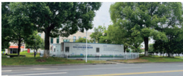
杭州富生智慧储能系统
