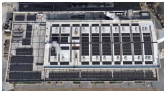
青浦污泥干化焚烧项目之光伏发电项目
