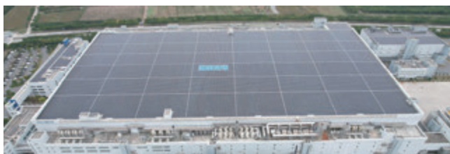
和辉光电 19.36MW 屋顶分布式光伏项目
