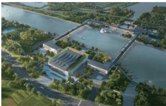
“一点”方厅水院智能化工程项目
