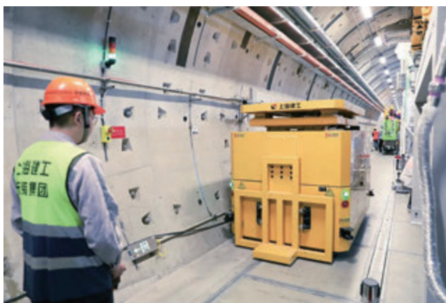
精密安装机器人助力国家大科学工程建设
