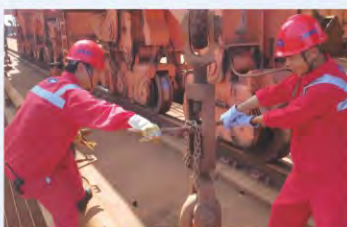
▲ 浦远公司—对大型设备检查加固
