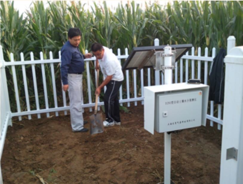
长三角投资公司下属上海长望气象科技股份有限公司利用专业特长，为贫困地区定制不同的小型自动气象站。图中工程人员正在安装自动土壤水分自动化测量系统，翻土将土壤水分传感器安装到指定深度
